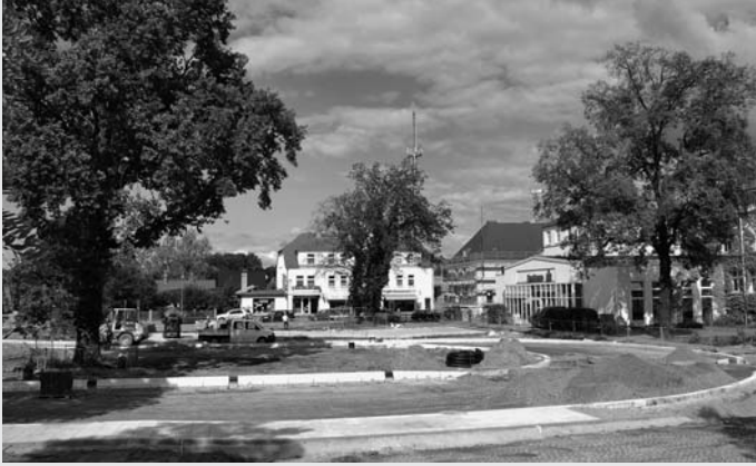
Noch Baustelle – bald moderner Busbahnhof
