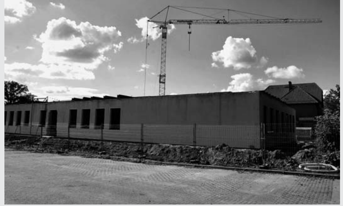
„Kopflös“ – Musiksaalgebäude mitten in der Sanierung
