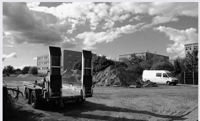
Kantschule in Vorfreude – Sportanlage im Bau
