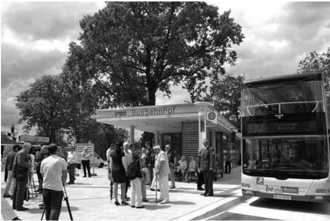
Der neue Falkenseer Busbahnhof mit modernem Pavillon.
